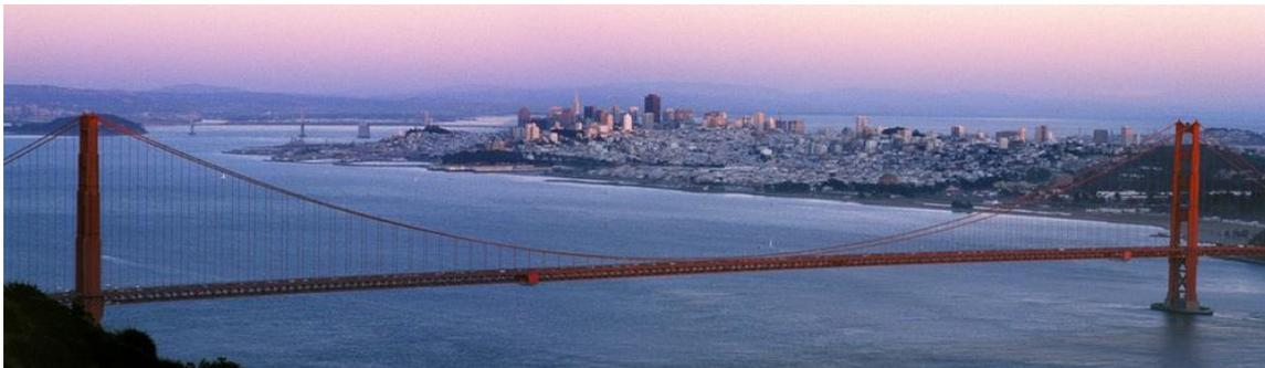
Die Fahrbahnhöhe über der Wasseroberfläche beträgt 84 m. Die Pfeilerhöhen über der Wasseroberfläche gemessen betragen je 227 m.
